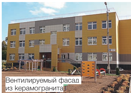
Вентилируемый фасад из керамогранита
