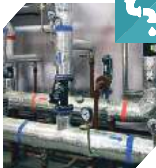
Электромонтажные и сантехнические работы
