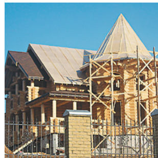
4. Сборка деревянного дома
