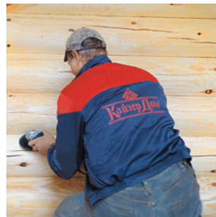
5. Шлифовка, конопатка, покраска
